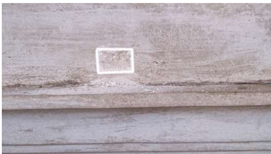
Campione n. 3 - sotto la cromia bianca originale si arriva all'intonaco come evidenza questa tassellatura.
